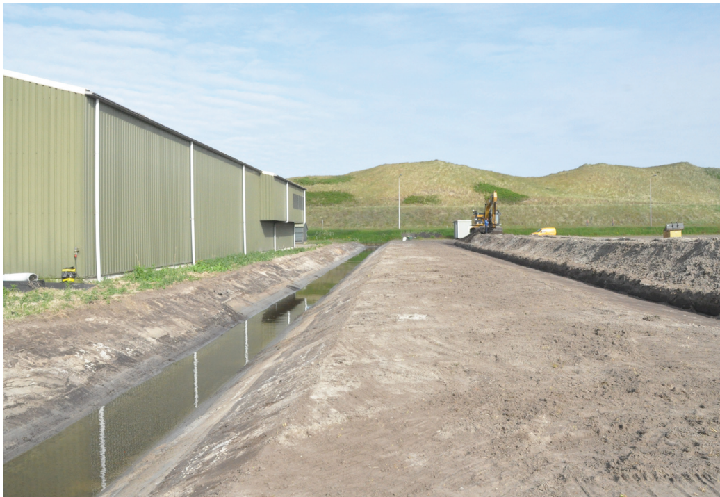
Afbeelding 5. Foto van de aangelegde sloot. Te zien is de bouwvoor, met daaronder het gele zandpakket S5020 en de overgang naar het grijze pakket S5030. Foto is genomen richting het westen.
